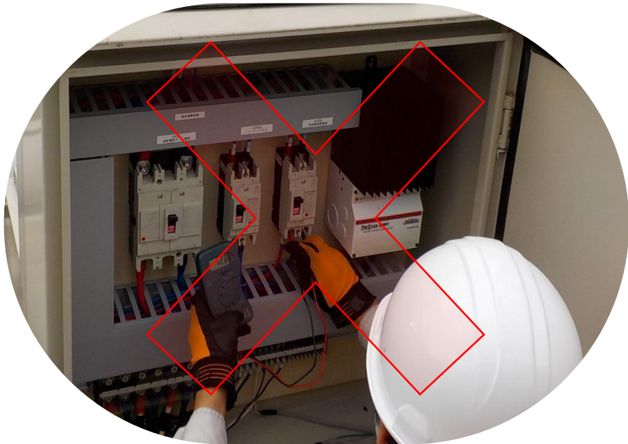
盤側での点検
